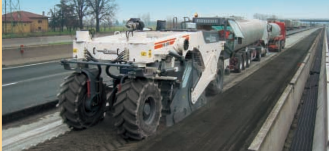
Durante il riciclaggio a freddo con bitume schiumato, la WR 2000 spinge l'autocisterna del bitume e quella dell'acqua davanti a sé. Entrambe le sostanze vengono addotte contemporaneamente e separatamente.
